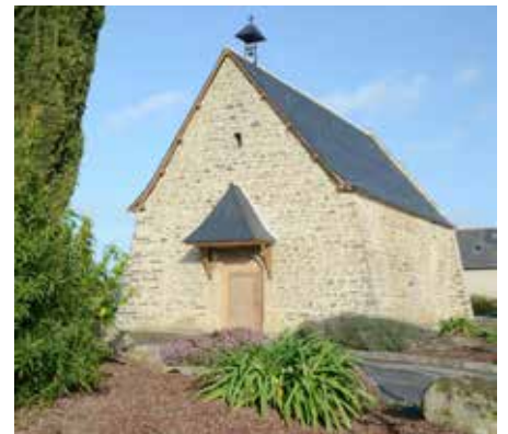
Rénovation de la chapelle St Job
