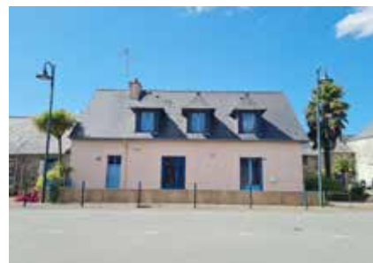
Acquisition et réaménagement d'une maison place Beau Soleil
