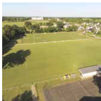
Rénovation des terrains de foot
