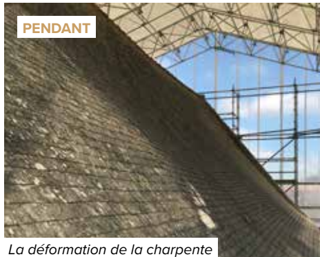
La déformation de la charpente
