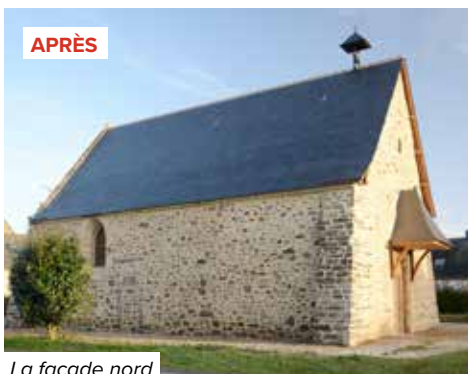
La façade nord
