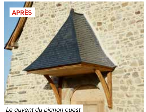
Le auvent du pignon ouest
