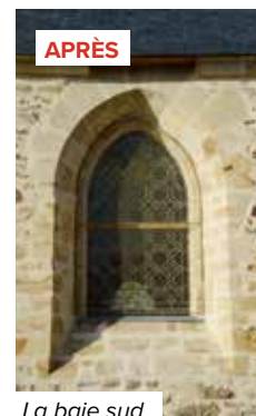
La baie sud
