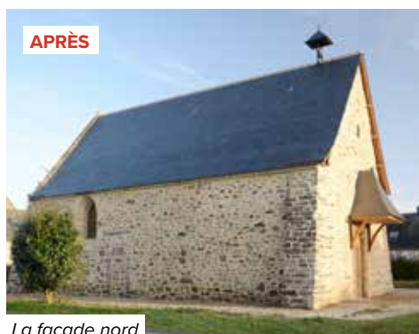
La façade nord
