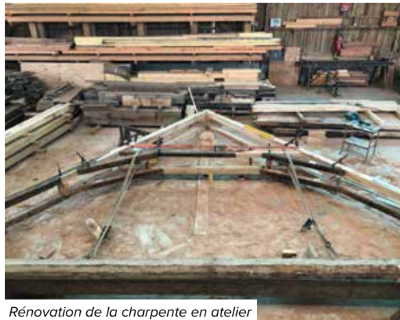
Rénovation de la charpente en atelier
