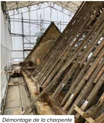
Démontage de la charpente
